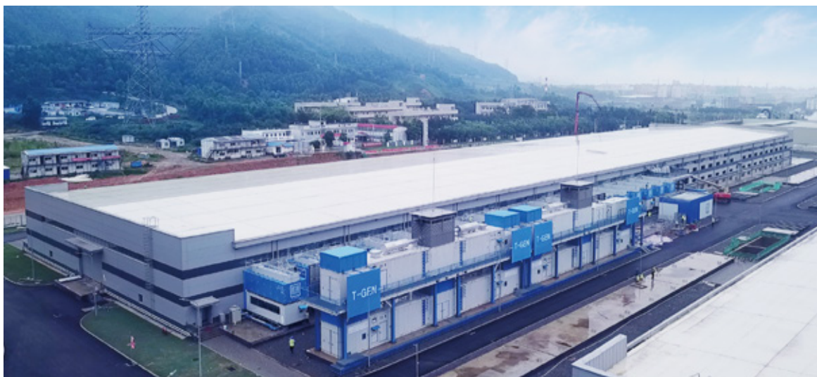
图2 预制全模块数据中心建设项目实景
